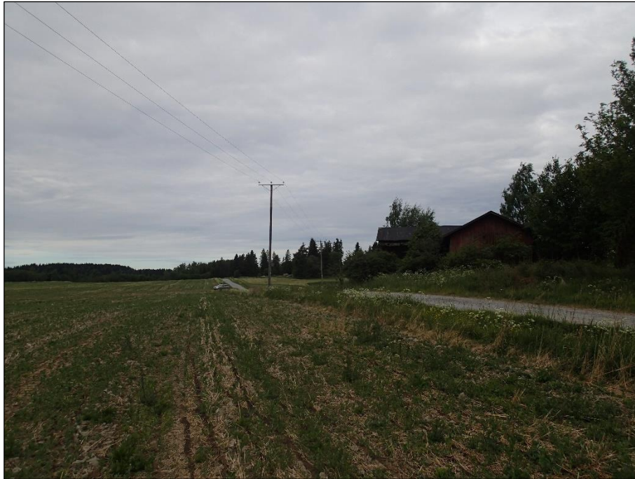
Tarkkuusinventoitua kaapelireittiä Kattelianmäen lounaispuolella. Länne.
