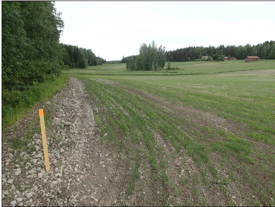
Pohjoisen pistohaaran reittiä Silvon tilan pohjoispuolella. Pohjoiseen.
